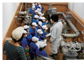
常盤中区配水池にて
